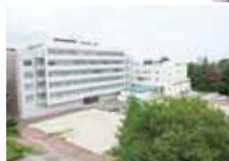
写真6 旧低層実験棟解体跡地 (共同棟南側)
