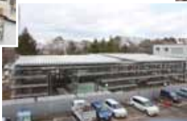
写真4 工事の進展状況 (2013年12月頃)
