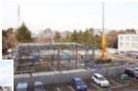
写真3 工事開始 (2013年12月頃)
