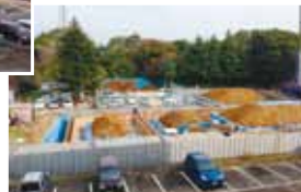
写真2 工事開始 (2013年10月頃)
